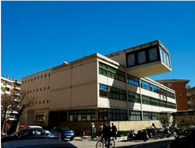
Biblioteca Pública del Estado Fermín Caballero, Arq. Miguel Fisac.
