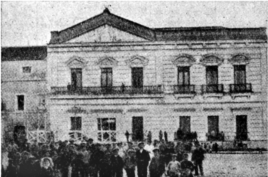
Estado de la construcción del Casino 1904
