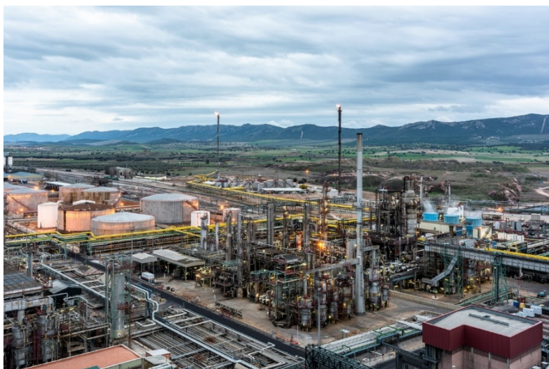
Complejo Repsol en Puertollano
